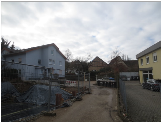
Abb. 3: Südlicher Teil des Plangebiets mit Baugrube (links)
