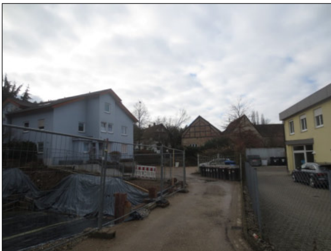
Abb. 3: Südlicher Teil des Plangebiets mit Baugrube (links)
