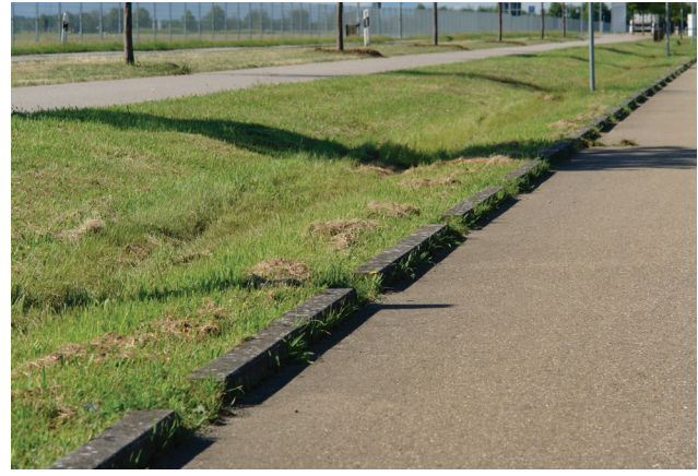
Abbildung 26: Auf Lücke gesetzte Bordsteine zur Ableitung von Straßenoberflächenwasser in die Versickerungsmulde (LUBW)
