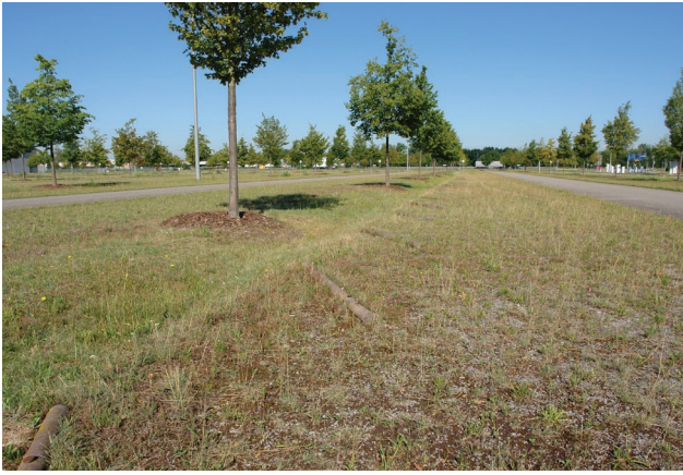
Abbildung 23: Niederschlagswasserversickerung auf der Parkfläche eines Messegeländes (LUBW)
