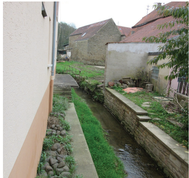
Abbildung 22: Mauer und Vorbau bilden Abflusshindernisse für Starkregenabflüsse. An solchen Engstellen wird Wasser abgeleitet und erzeugt häufig große Schäden an den anliegenden Gebäuden (Cassel).
