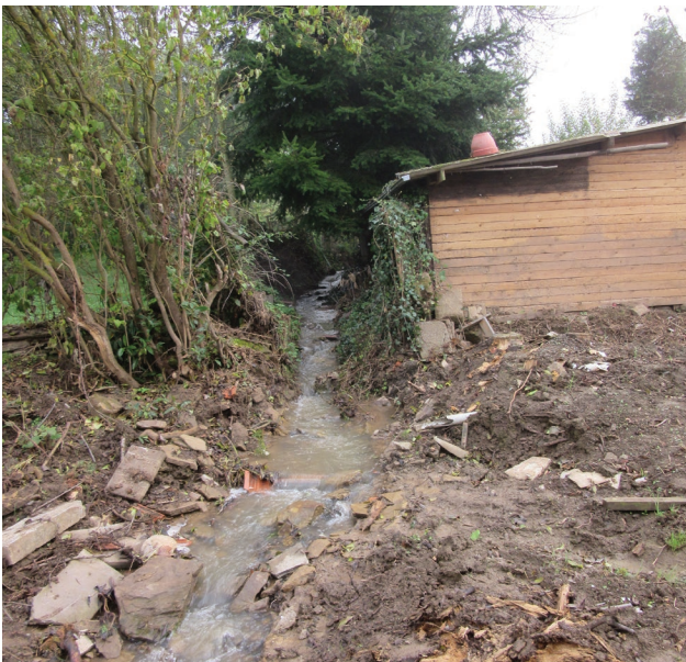
Abbildung 21: Graben, der bei einem Starkregenereignis zu einem Hauptabflussweg für Hangwasser wurde („schlafendes Gewässer“) (Cassel)
