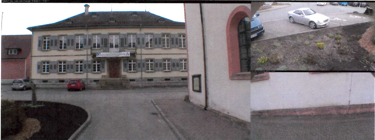
Abb.: Bilder aus Befahrungsvideo Stadt Sulzburg
