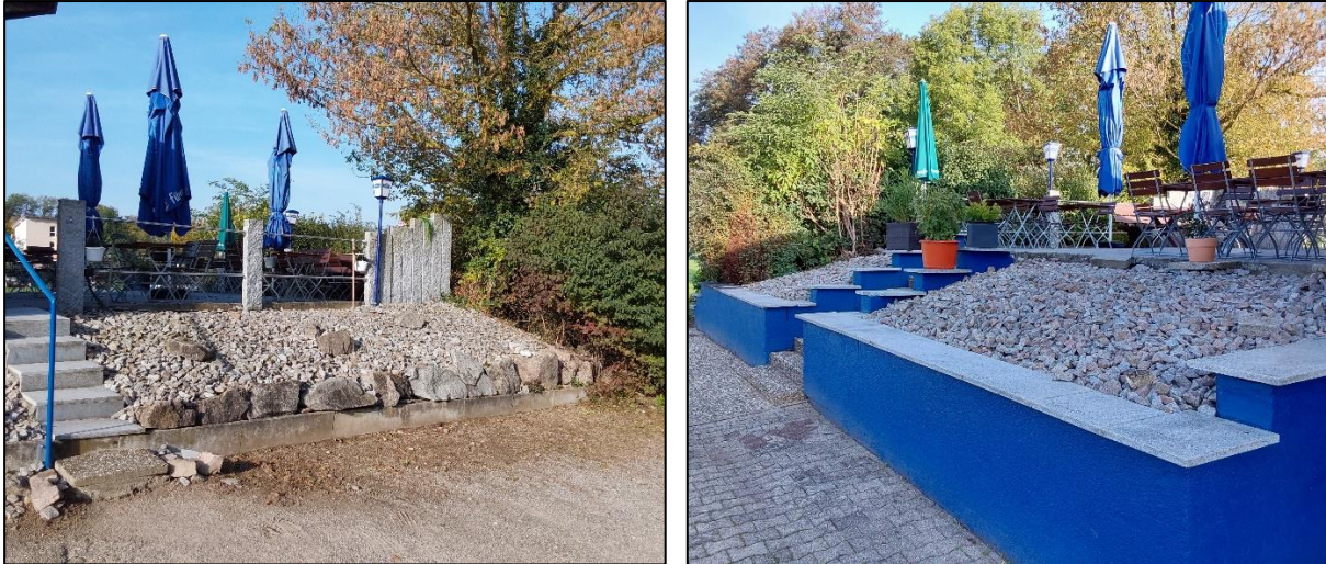
Abb. 6 + 7: Steinschüttungen entlang der Terasse der Sportgaststätte.
