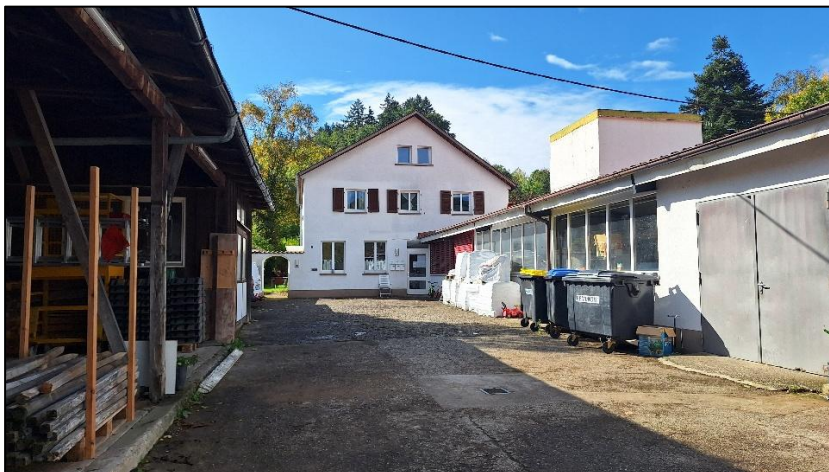
Abb.2: Blick von Nordosten her Richtung Süden auf die Scheunen sowie das Wirtschafts- und Wohngebäude.
