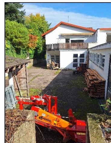
Abb.3: Blick von Südwesten her Richtung Nordosten auf die Wirtschaftsgebäude.
