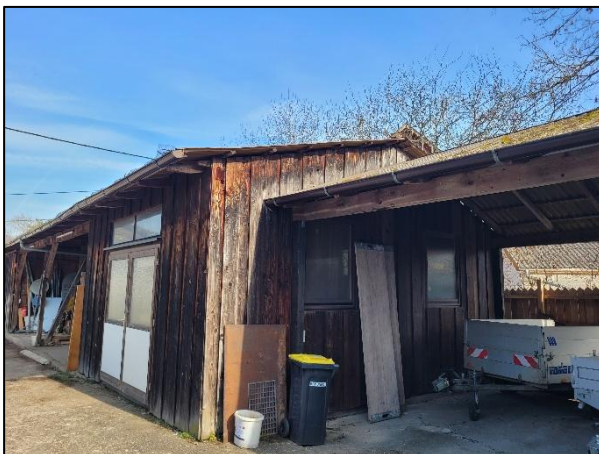
Abb. 7: Überdachte Lagerfläche sowie geschlossene Scheune angrenzend zur Garage, nordöstlich des Plangebiets.
