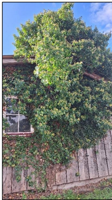
Abb. 12: Efeubewachsene Scheune im Norden des Plangebiets.
