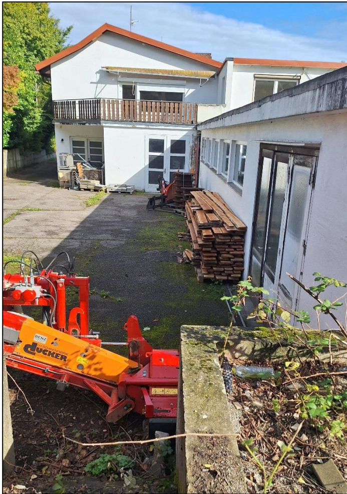
Abb. 14: Potenziell für Eidechsen nutzbare Verstecke entlang der Gebäudewand.
