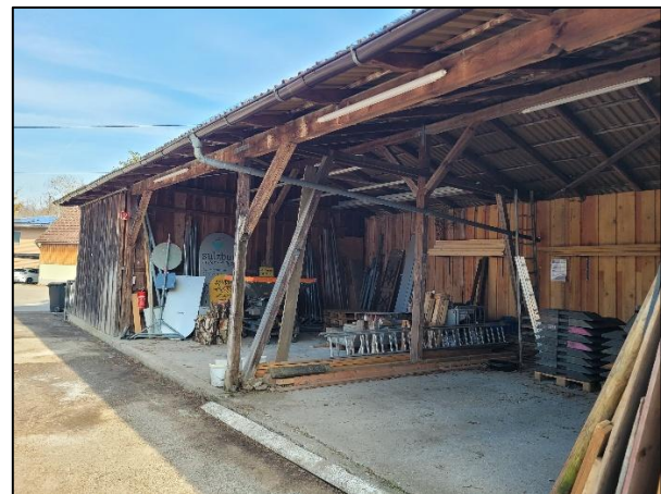
Abb.8: Offene Scheune im Plangebiet nordöstlich gelegen.
