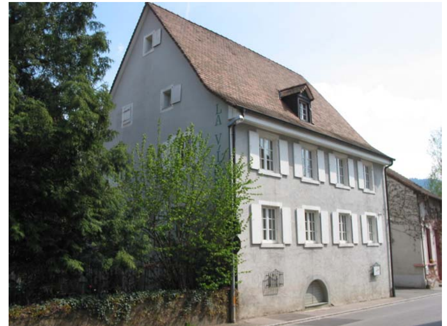
Ansicht des Gasthauses von Nordwesten
