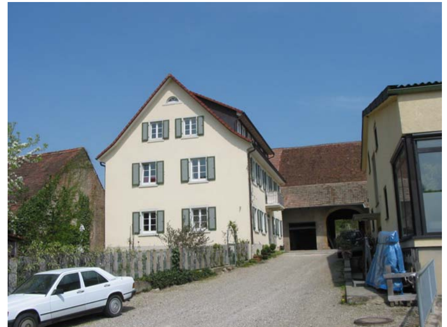
Ansicht der Hofanlage von Südwesten
