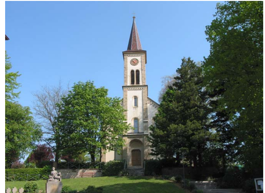
Ansicht der Pfarrkirche von Süden mit umgebenden, erhaltenswerten Grün- und Freiflächen
