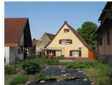
Ansicht des Gebäudes von Süden
