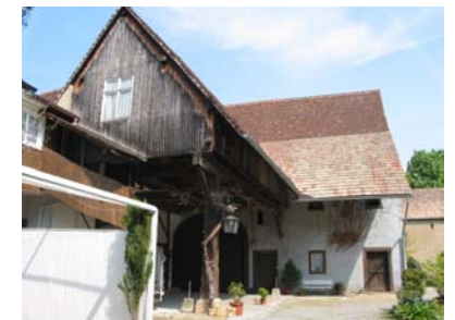
Ansicht der Scheunen von Westen
