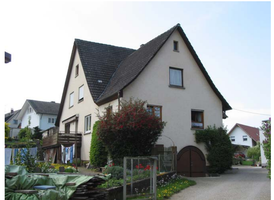
Ansicht des Wohnhauses von Nordosten
