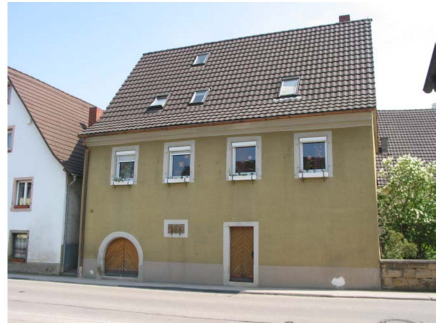
Ansicht des Wohnhauses von Westen
