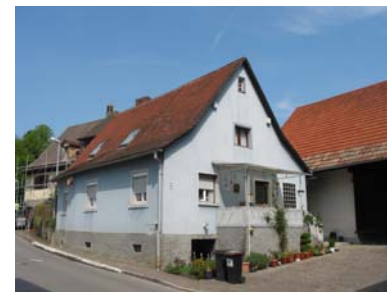
Ansicht des Wohnhauses mit rückwärtiger Scheune von Südwesten
