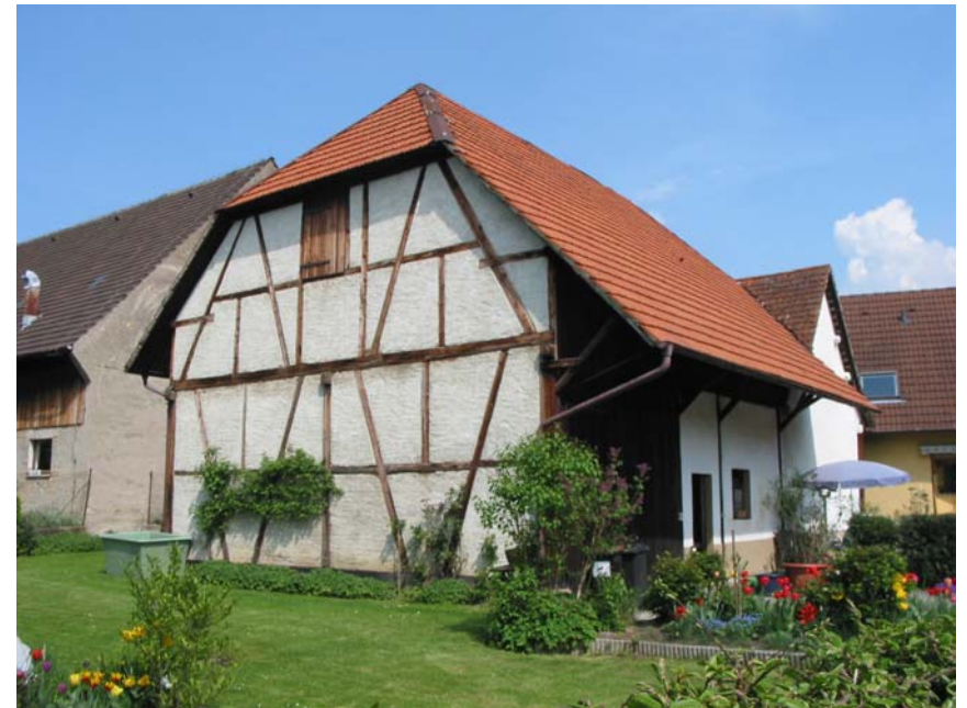
Ansicht der Scheune von Südwesten
