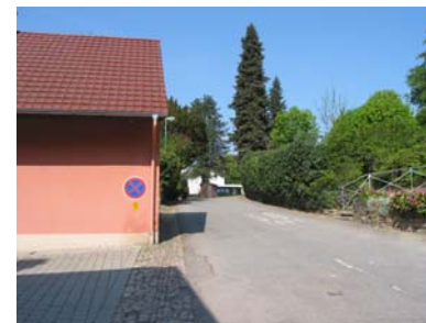
Blick nach Westen auf Höhe von Gebäude Weinstrasse 6
