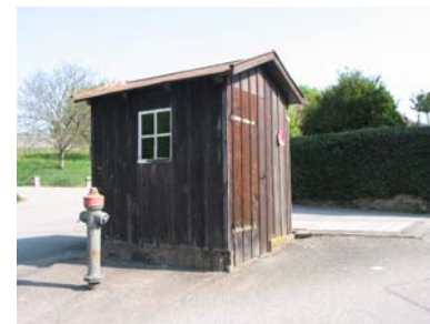
Ansicht der Brückenwaage von Süden
