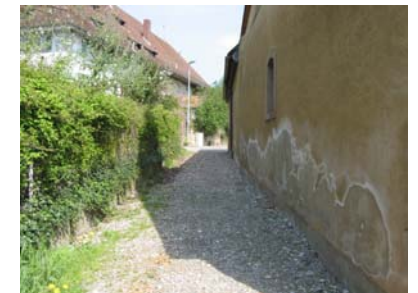
Blick nach Nordosten entlang des Fußweges
