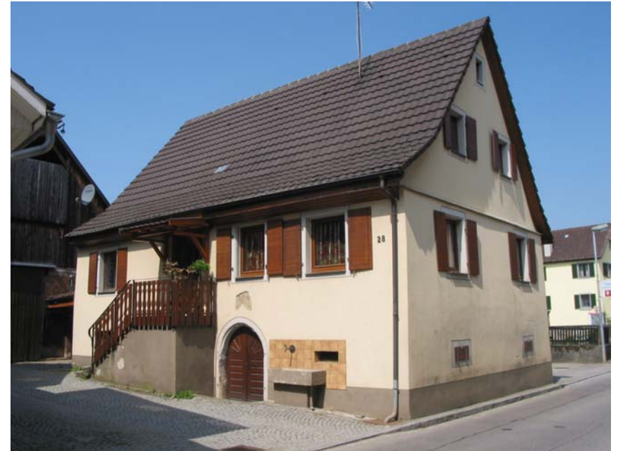
Ansicht des Winzerhauses von Südosten
