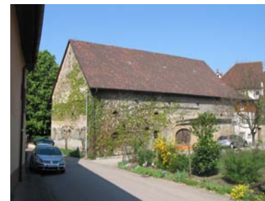
Ansicht der Scheune von Südosten
