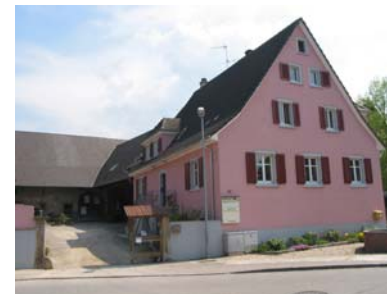
Ansicht des Wohnhauses von Westen
