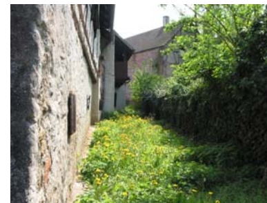
Bereich des kanalisiertes Bachlaufes neben Gebäude Brunnengasse 2
