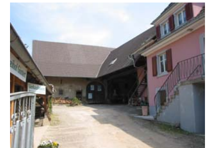
Ansicht der Scheunen von Westen
