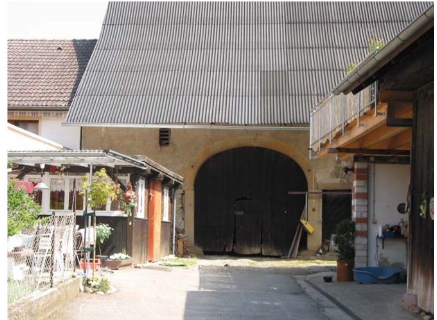
Ansicht der Scheune von Südwesten
