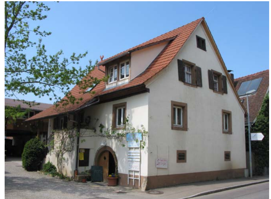
Ansicht des Winzerhauses von Südosten
