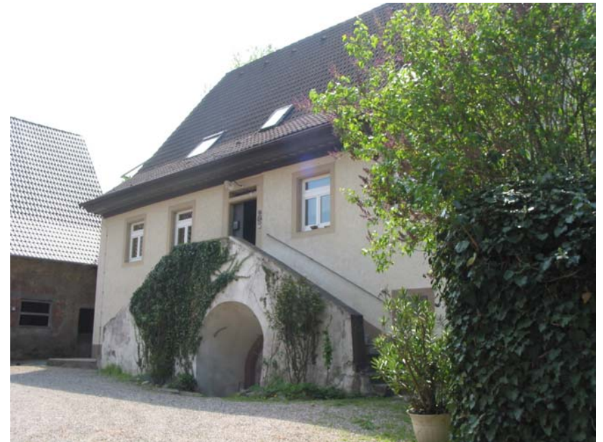
Ansicht der Hofanlage mit Wohnhaus von Norden
