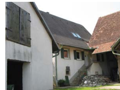
Ansicht des Wohnhauses von Nordosten
