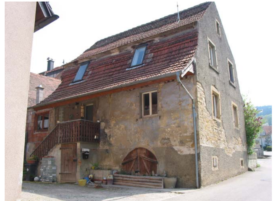
Ansicht des Wohnhauses von Westen
