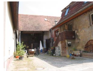
Blick in den Hof von Südwesten
