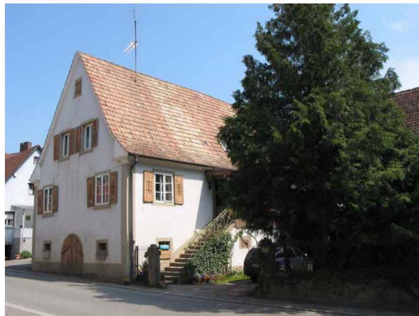
Ansicht der Hofanlage von Südwesten
