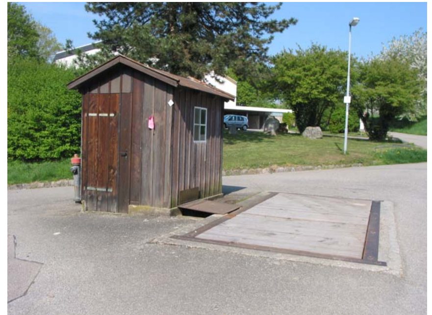
Ansicht der Brückenwaage von Osten
