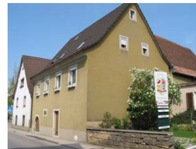
Ansicht der Hofanlage von Südwesten
