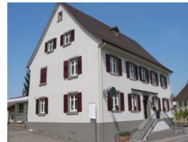
Ansicht des Gasthauses von Süden
