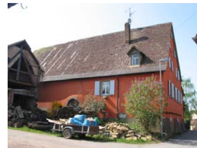
Ansicht des Wohnhauses von Nordosten
