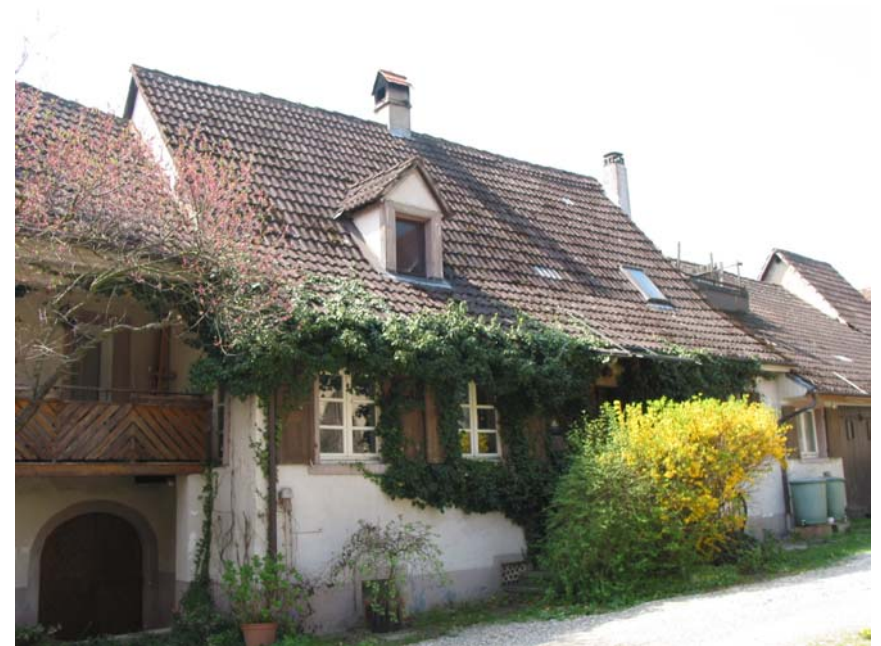
Ansicht des Wohnhauses von Nordosten
