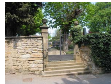
Eingangssituation des ummauerten Friedhofsbereiches von Süden
