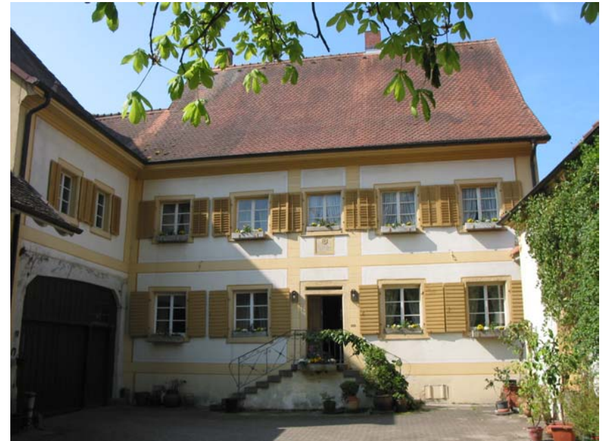
Ansicht des Wohnhauses von Nordosten
