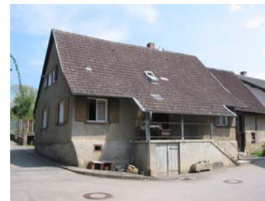
Ansicht des Wohnhauses von Westen
