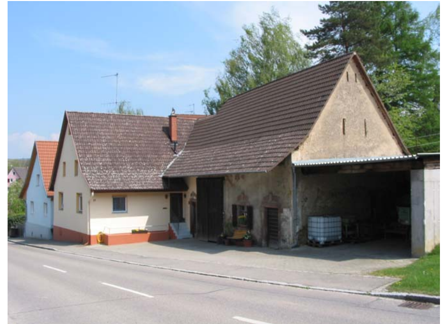
Ansicht der Hofanlage von Südwesten
