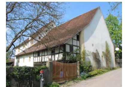
Ansicht der Scheune von Südosten
