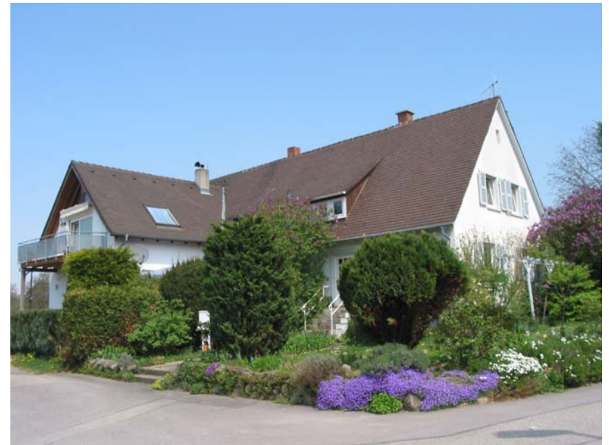
Ansicht des Gebäudes von Südwesten
