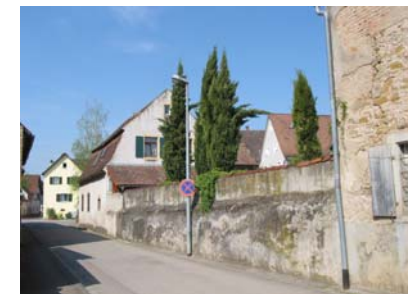
Blick nach Westen auf Höhe von Hausnr. 2
