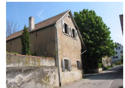
Ansicht des Nebengebäudes von Südwesten
