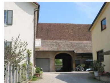
Ansicht der Scheune von Südwesten
