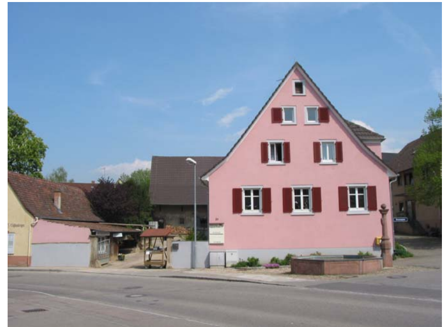
Ansicht der Hofanlage von Südwesten
