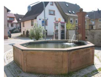
Ansicht des Brunnens von Nordwesten
