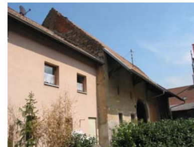
Ansicht der Scheunen von Südwesten
