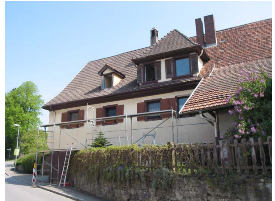
Ansicht des Gebäudes von Südwesten
