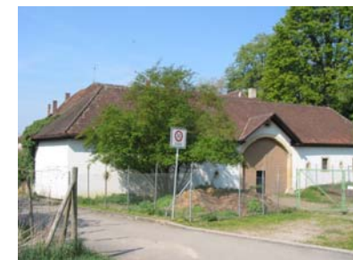
Ansicht des rückwärtigen Ökonomiegebäudes von Osten
